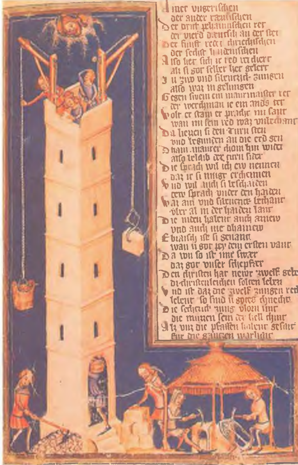
Vinçler, harcı sepet içinde, taşları da kıskaçlarla inşaatın tepesine çekiyor. İstü hasır çatı ile kapalı locada taş yontucuları çalışıyor.
