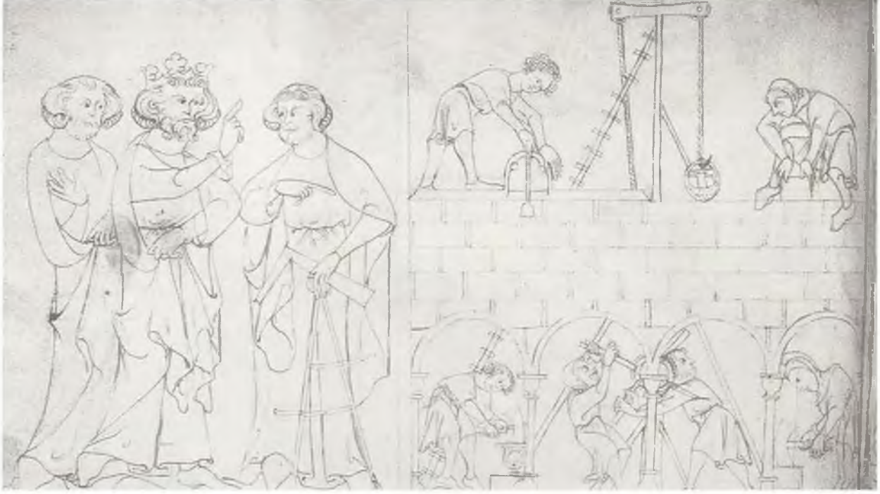
Kral ve elinde gönye ve pergel ile Üstat Mason. St. Albans Manastırının inşaatı, 14.yüzyılın başı. Resmin sağ üst tarafında bir usta tesviye ile duvarın yatay hatlarını kontrol ederken bir diğeri taş döküyor; resmin alt tarafında taş yontan işçilerle vinci çalıştıranları görüyoruz. Üstat Mason elinde görevinin sembolleri olan gönye ve pergeli tutmaktadır.
