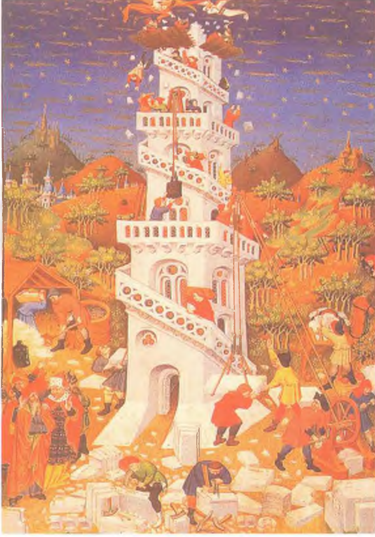
Bâbil Kulesinin inşaatı. Bu tür resimler sayesinde zamanın inşaat zanaatları hakkında bilgi sahibi olabilmekteyiz. Ön planda Mason avadanlıkları, taşların ölçülmesi ve yontulması; sol yanda harcın karıştırılması; sağ yanda da taşların üst katlara çıkarılması işçiliklerini görmekteyiz. Minyatürün üst tarafında resmedilen ilk iş kazasını, iskeleden düşen bir işçiyi görüyoruz. 15.yüzyıl minyatürü.
