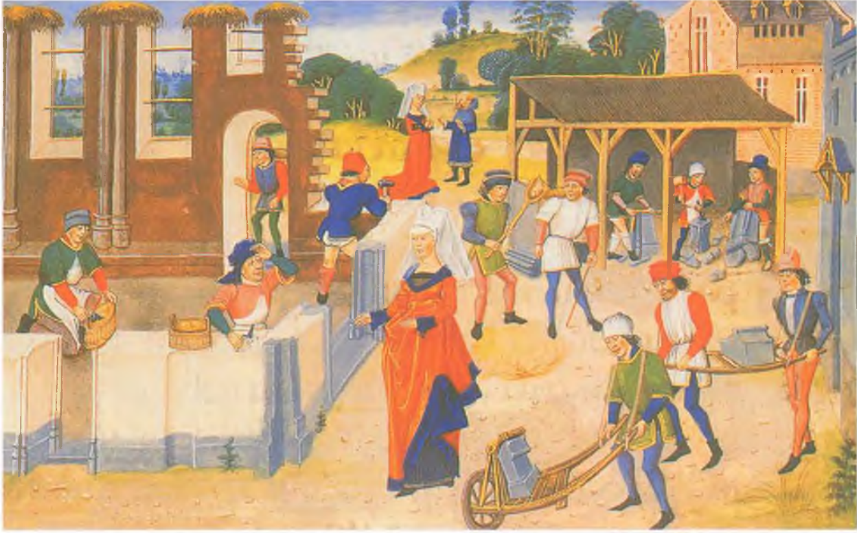
Bu 15.yüzyıl minyatüründe resmedilem Mason Locasının yanları açık olup inşaata bitişiktir. Burada aletler saklanır, taş yontucuları çalışırken rüzgârdan korunurlar, çıraklar eğitilir, yemek yenir ve oturulurdu.
