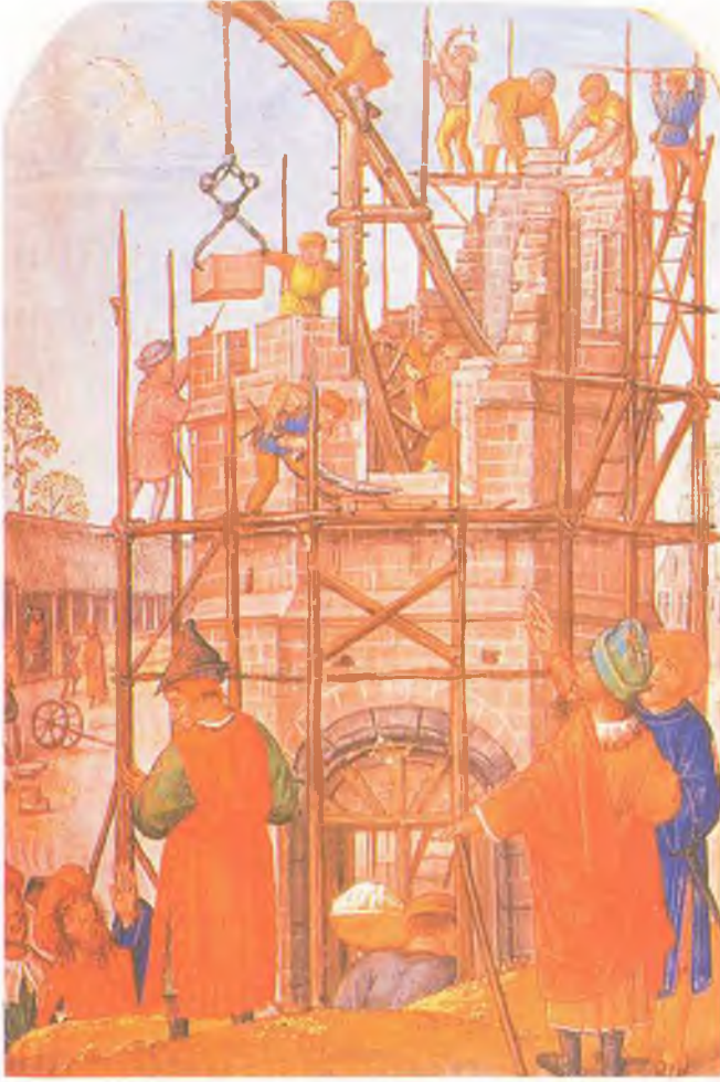
Birbirine iplerle bağlanmış ahşap direklerden yapılmış iscele ve çarkı el gücü ile çevrilen vinç.
