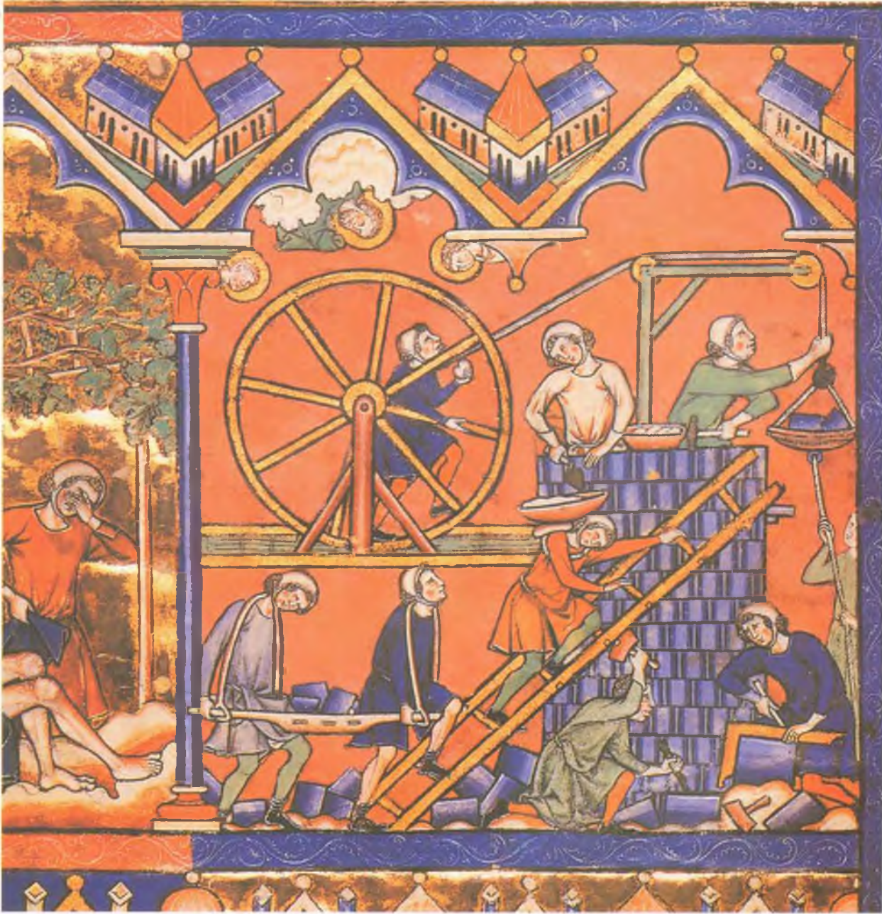
Vincin sepeti ile yukarı çekilen taşları malası ile ören duvarcı ustası. Duvarın dibinde başka bir usta, daha önce yontulan taşların dik açılarını gönye ile kontrol ediyor.
