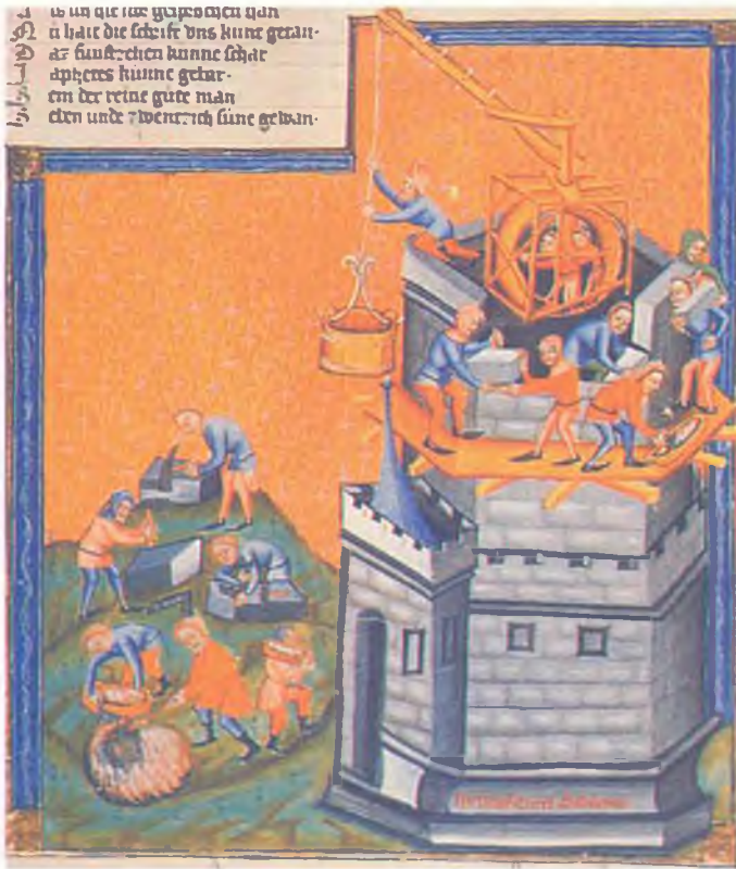
İşçilerin çarkının içinde yürüyerek çalıştırdıkları vinç.
