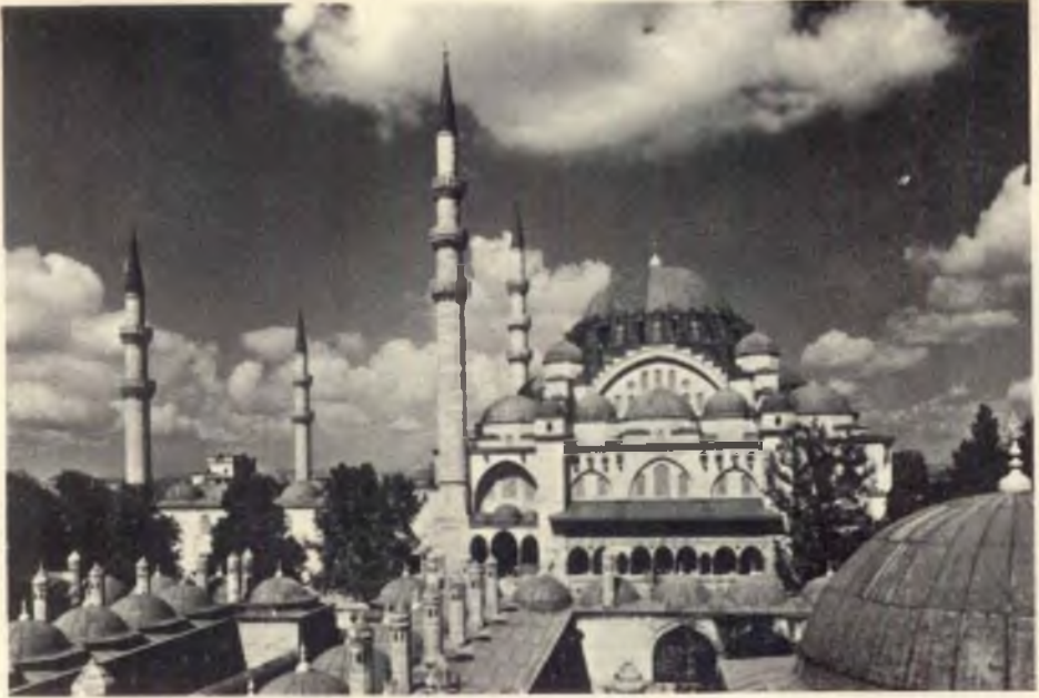
SÜLEYMANİYE CAMİİ (Mimar Sinan) İst. Foto : Şinasi BARUTÇU
