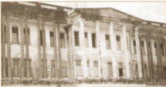
Monrovia'da Büyük Loka binası. Binada 1980 darbesinin izleri hala gözüküyor.
