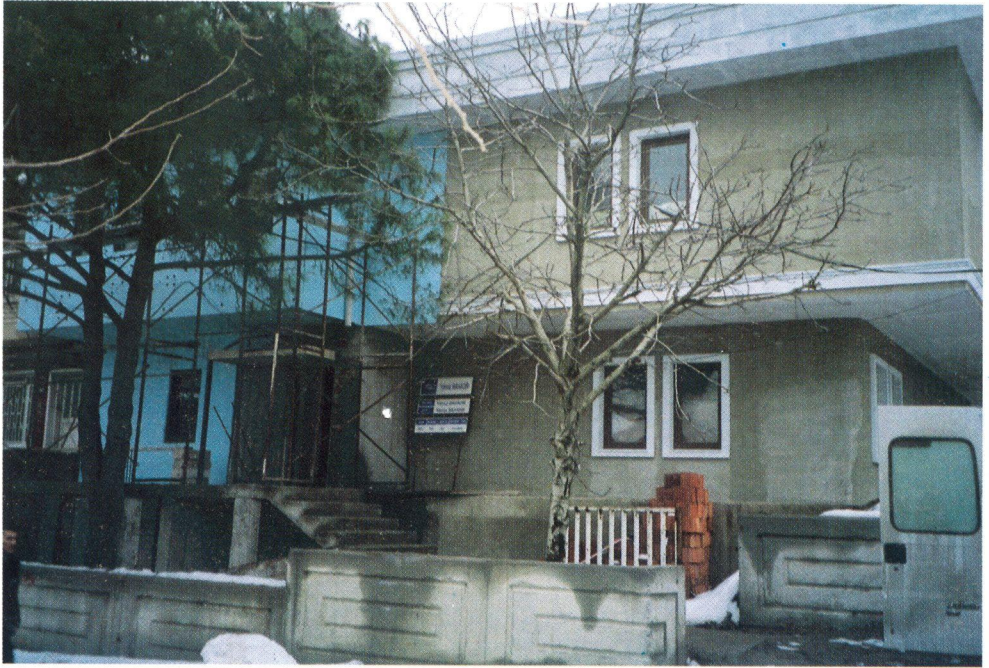
Fotoğrafta yeşil boyanmış olarak görülen birinci kısım, mavi boyalı bölüm ise ikinci kısımdır. Mavi, ısı tecridi için kullanılan astar malzemenin rengidir, son kat boyası yapıldığı zaman yeşile dönüşecektir.
