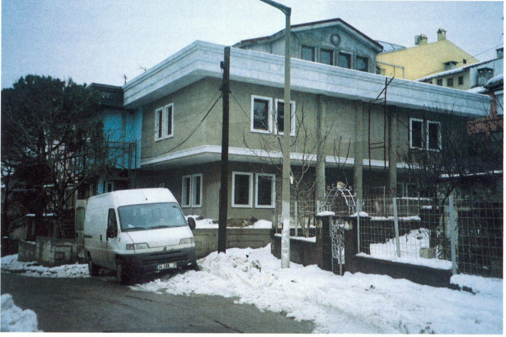
Kadıköy Binamız İnşaatının Son Durumu (11.01.2002)
