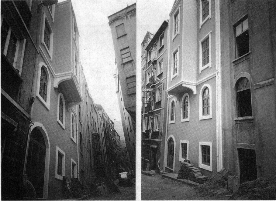
Eski Çiçekçi Sokağı servis binası inşaatımızdan görüntüler.
